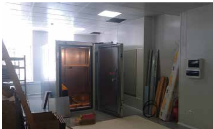
2 Камеры устанавливаются в новом отремонтированном помещении
