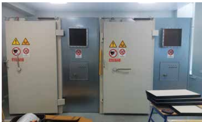
1 Экранированные камеры Frankonia в процессе сборки
