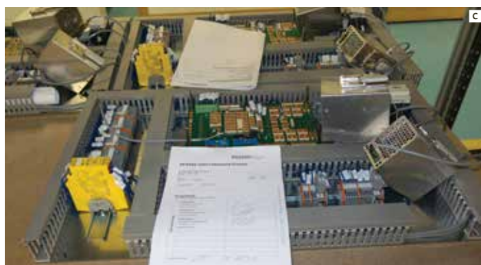
Сборка электронных модулей — монтажа кабельканалов A , самопроверка B , готовые модули после тестов C
